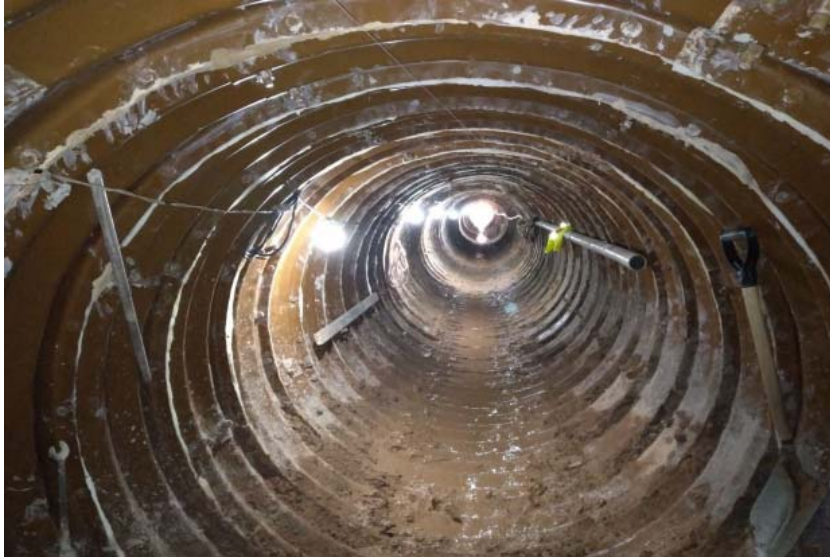
Foto 11 – Ampliação Bueiro – Km 29+320 [2]
