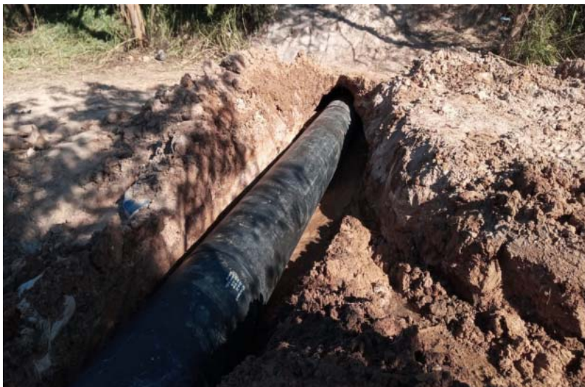
Foto 10 – Ampliação Bueiro – Km 14+900 [1]
