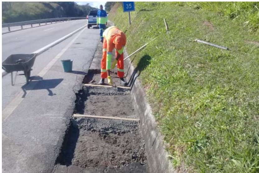
Foto 6 – Recuperação de Sarjeta – Km 35+000 Norte [2]
