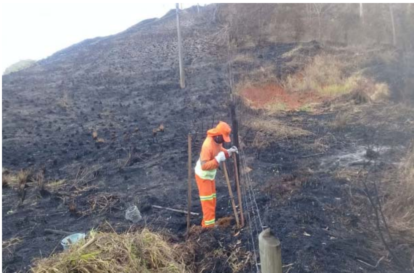
Foto 8 – Reparo de Cercas – Km 09+600 Norte
