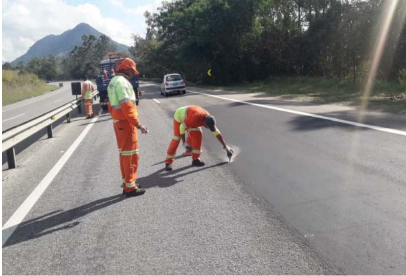
Foto 3 – Implantação de Tachas – Km 19+000 Sul
