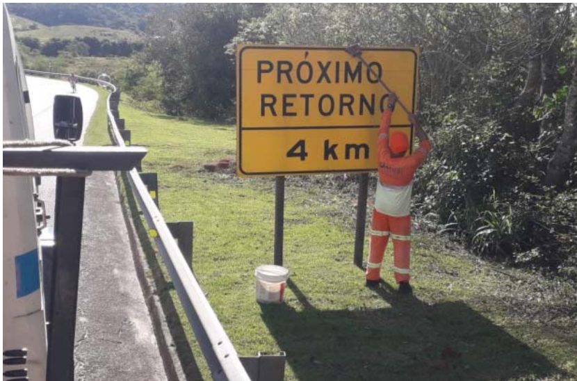
Foto 2 – Limpeza de Placa – Km 04+000 Sul
