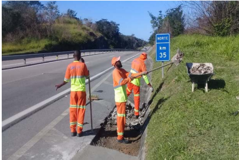
Foto 5 – Recuperação de Sarjeta – Km 35+000 Norte [1]
