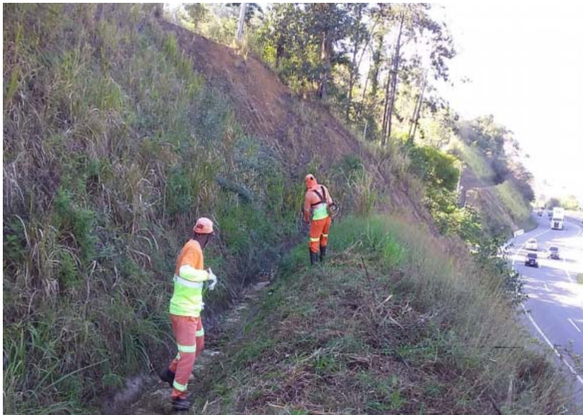
Foto 4 – Limpeza de Valeta de Corte – Km 07+000 Sul
